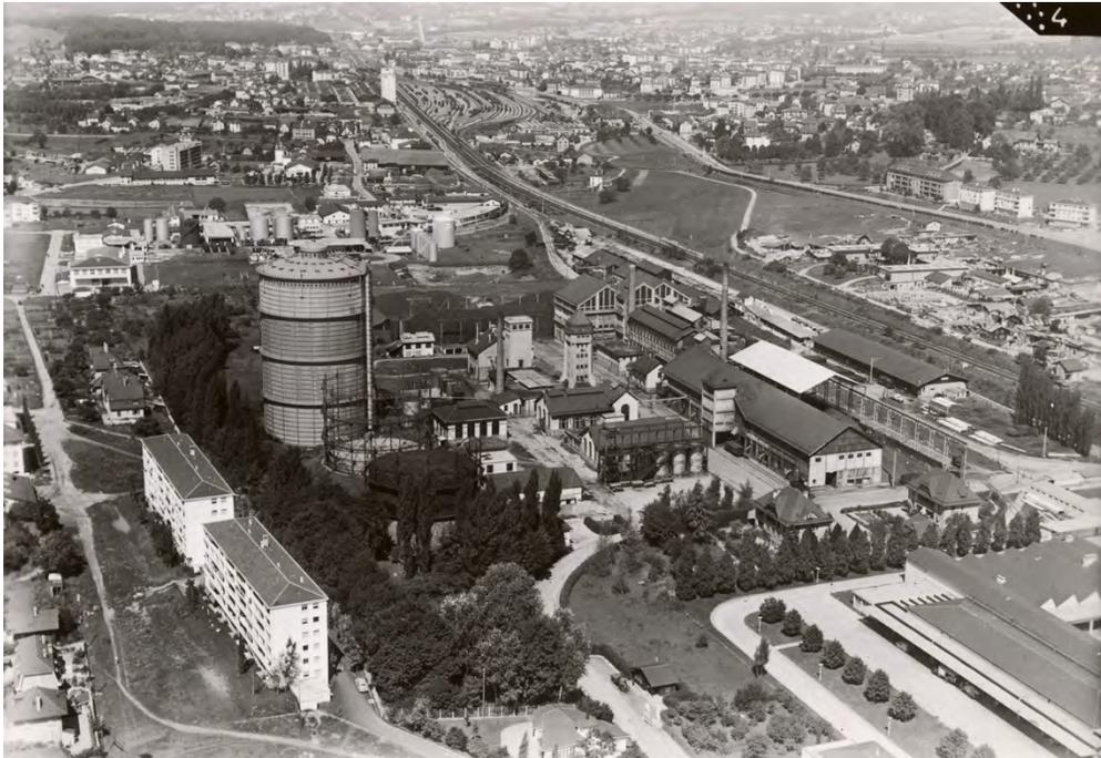
Fig. 6 : Aéroport de la Blécherette, Vue aérienne du site de l'usine à gaz de Malley et du gazomètre « sec » de 40'000m<sup>3</sup>, 18.08.1956. ©Musée historique de Lausanne
